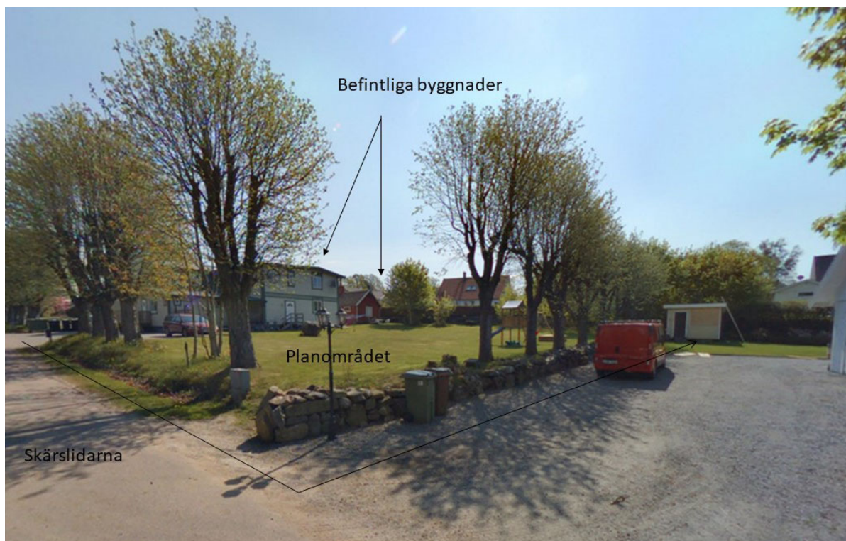
Planområdet sett från nordväst. De befintliga byggnaderna består av huvudbyggnaden i gråvitt med gröna detaljer och ett äldre uthus i rött. Stenmuren ligger på Tröinge 6:45 och del av uppgrusad yta ligger inom en outredd samfällighet och tillhör inte fastigheten Tröinge 5:25.
