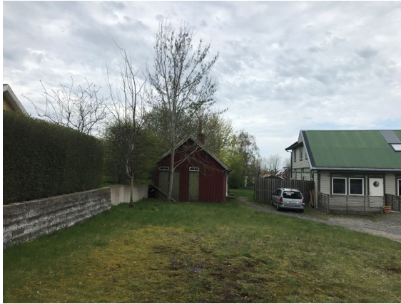
Stödmur i fastighetsgräns i söder
