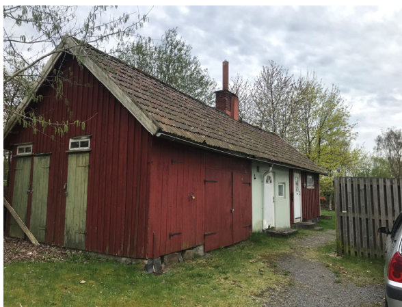
Befintligt uthus som avses rivas
