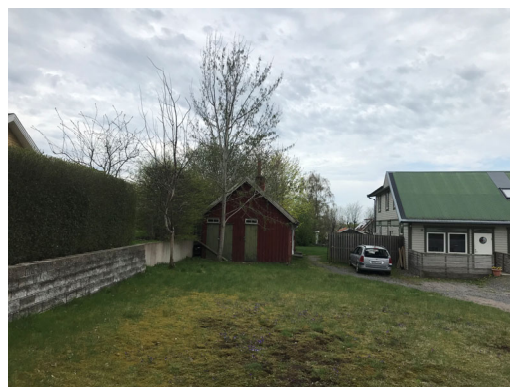
Befintlig stödmur i fastighetsgräns mot Tröinge 6:71
