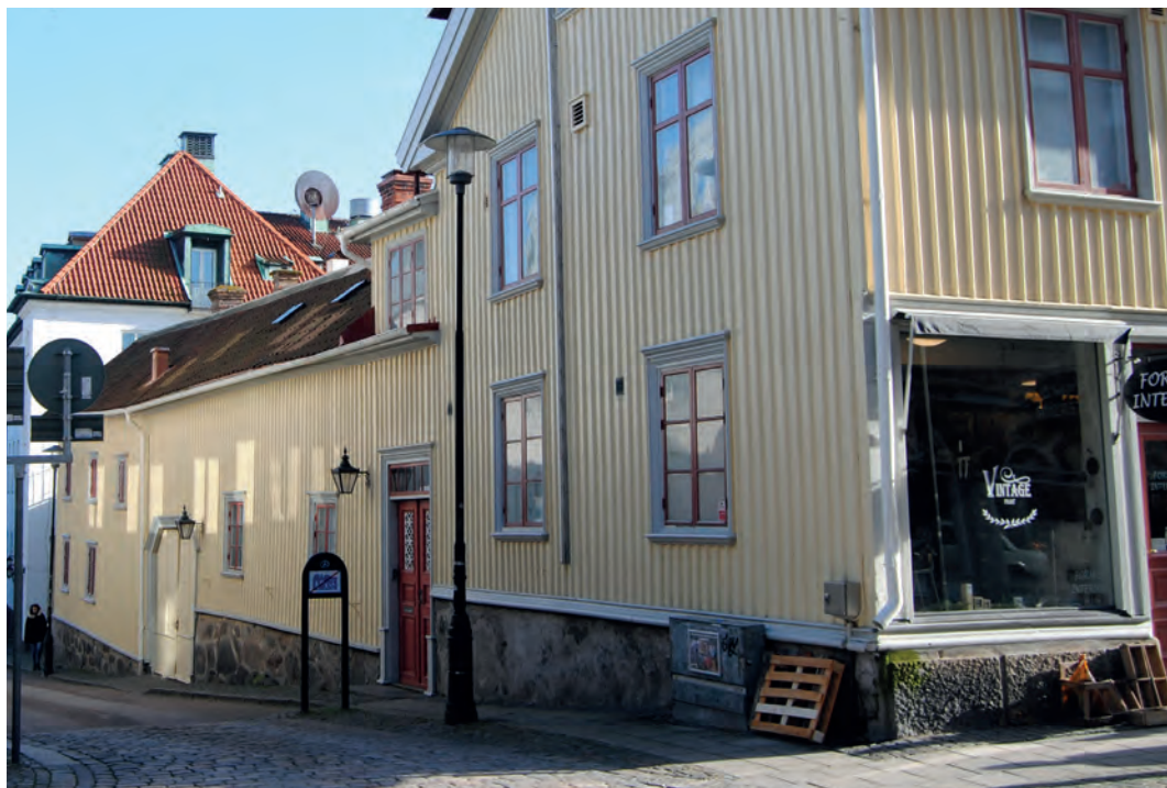
Grundmuren till Pokalen 5 har grovt kluven, murad marksten. Notera sockeln under skyltfönstret mot Storgatan där senare påförd grov puts ska efterlikna kvaderstenar.
