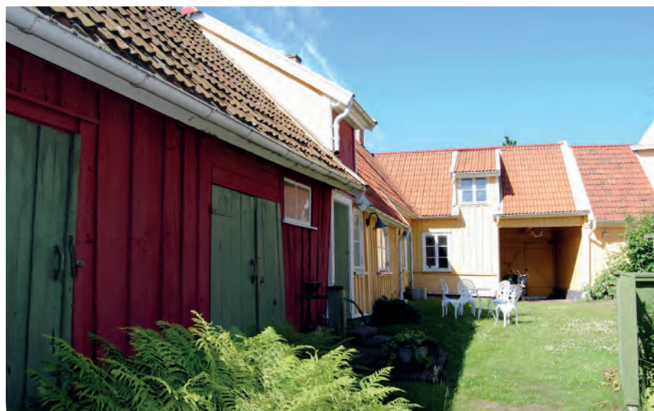
Välbevarad innergårdsmiljö i kvarteret Laxen.
