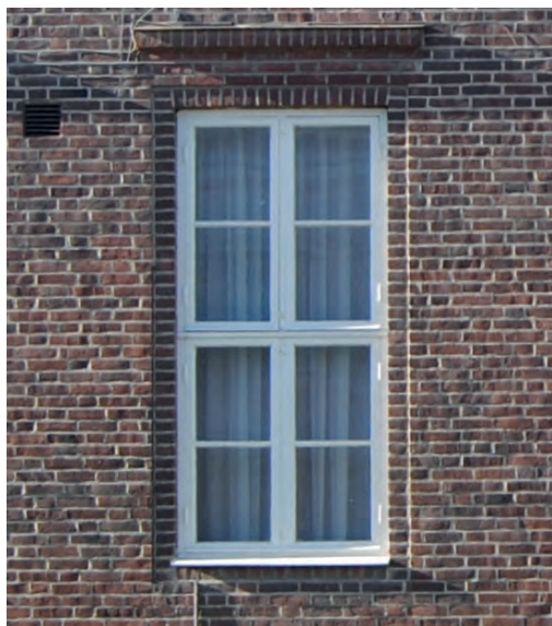
Ursprungliga fönster ger karaktär åt byggnaden.
