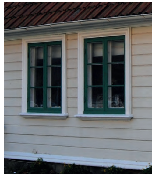
Sidohängda träfönster av en typ som var vanlig både under andra halvan av 1800-talet och in på 1920-talet.
