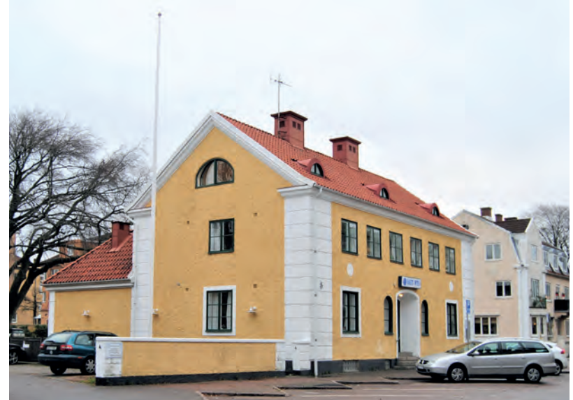
IOGT-huset i kvarteret Nyckeln har tidigare varit ett bostadhus.
