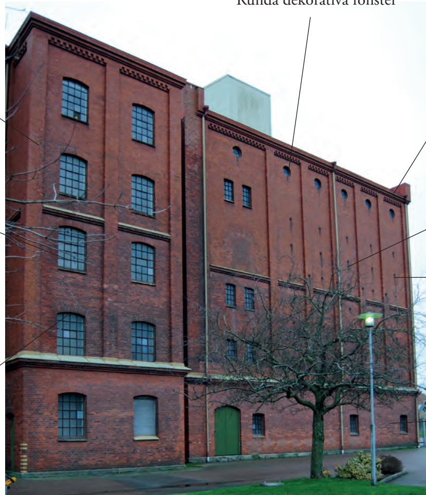
Valskvarnen, Sjövisaren 8, uppförd 1904-1905.
