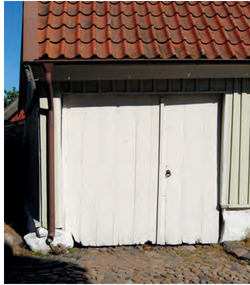
Portdörrar i enkel brädkonstruktion.
