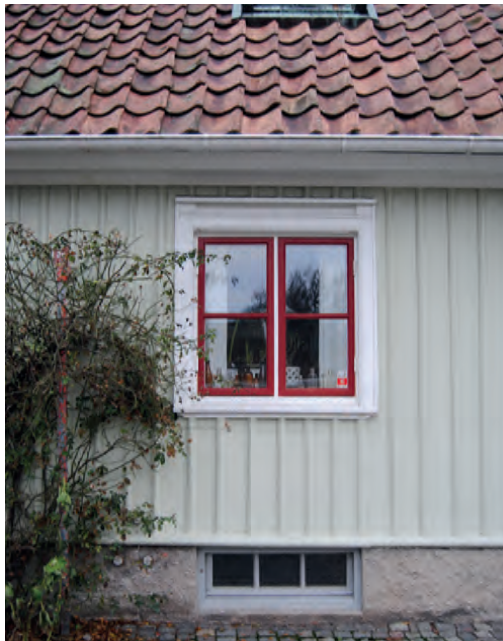
Med kontinuerligt, rätt utfört underhåll kan tegeltak, fönster och panel hålla i hundra år eller mer.
