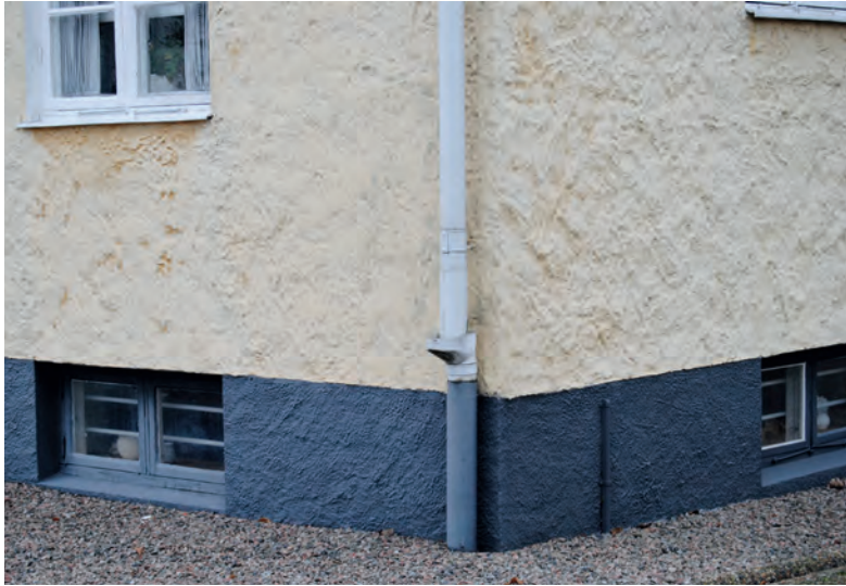
Falkenbergsputsens struktur varierar beroende på vilken murare som utförde arbetet. Ovan en kryssformad variant.
