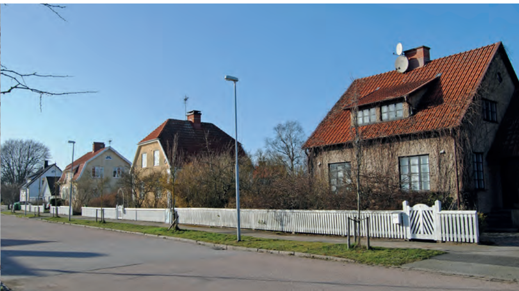
De välbevarade 1920-talsvillorna i kvarteret Mältaren ramas in av vita spjälstaket med vackert utformade grindar.
