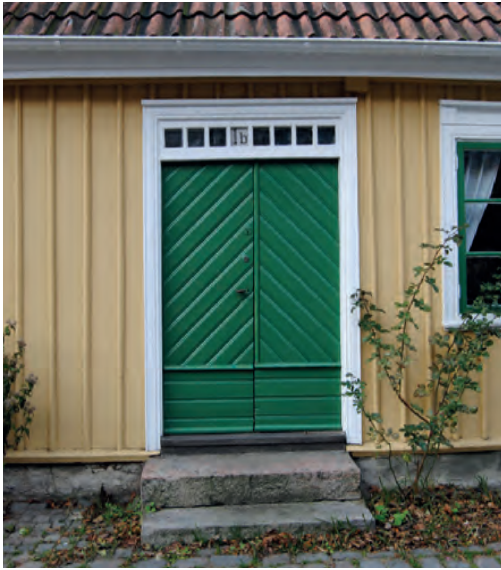
Panelklädd pardörr med överljusfönster.
