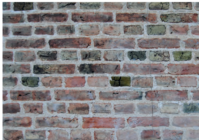
Handslaget tegel har en mängd olika nyanser som ger liv åt fasaden.
