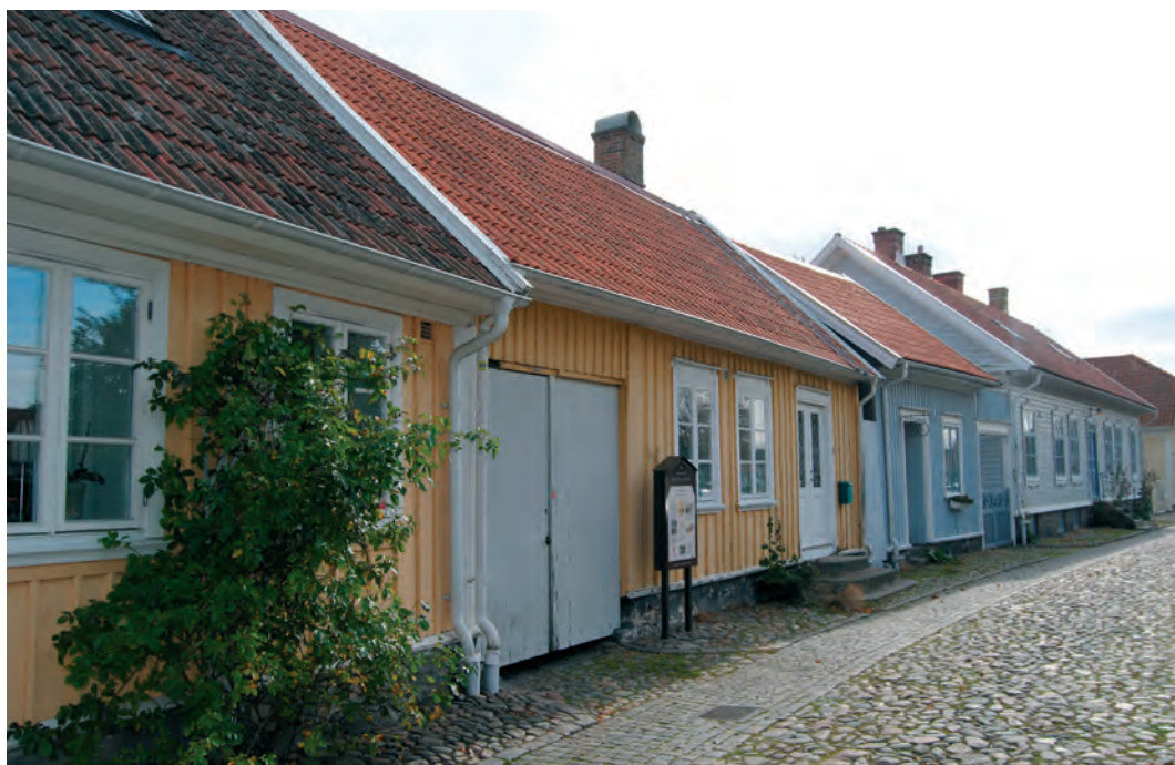
Gamla stan, en miljö som är utpekad som riksintressant för kulturmiljövården. Byggnaderna har även skyddsbestämmelser i detaljplan.
