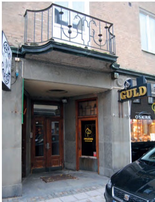
Välbevarat entréparti med butiker i kv Vitan.
