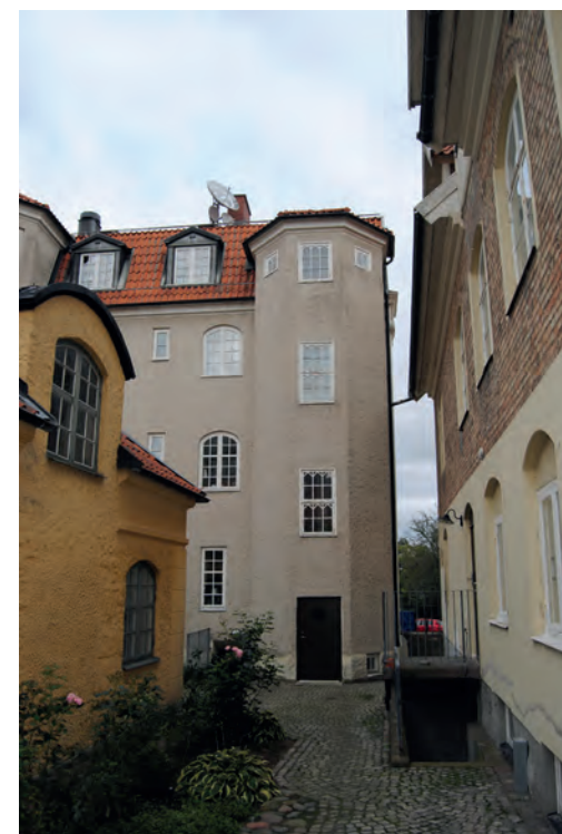
Gårdsinteriör från Gästgivaregården 9. Fastigheten har en välbevarad gårdsmiljö och innehåller flera värdefulla byggnader.
