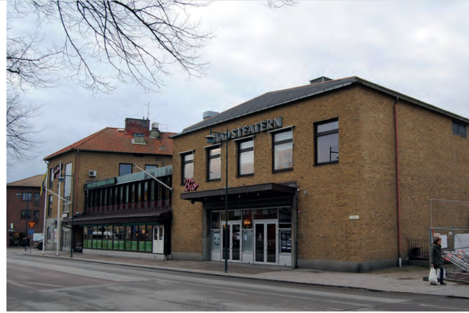
Tv: Modernistiskt affärs- och kontorshus i kvarteret Holger.
